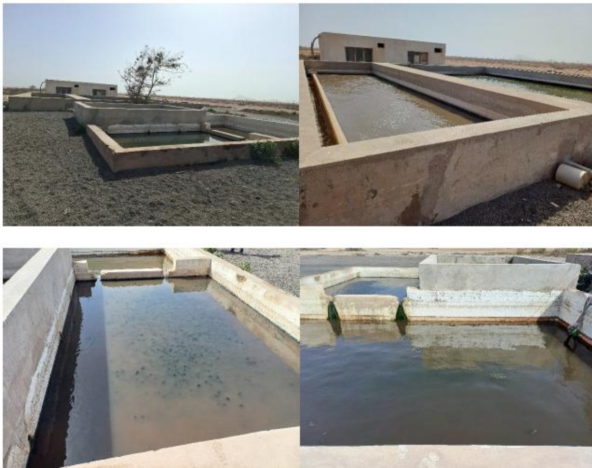
Figura 2.1.5.2 | Localização e imagens da ETAR existente no aeroporto do Sal (SID).
