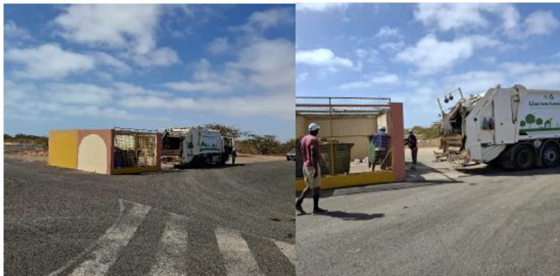
Figura 2.1.11.5 | Locais de armazenamento temporário dos resíduos no aeroporto da Boavista (BVC).
